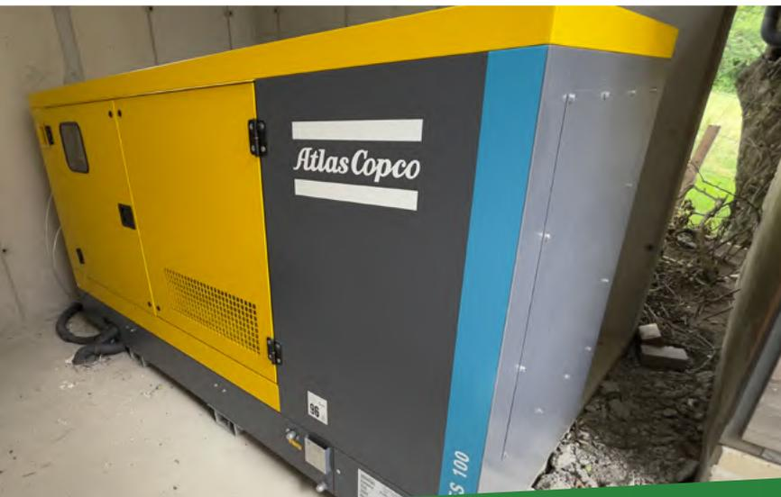
mobiles Aggregat für die Stromversorgung der Pumpstationen und -werke
